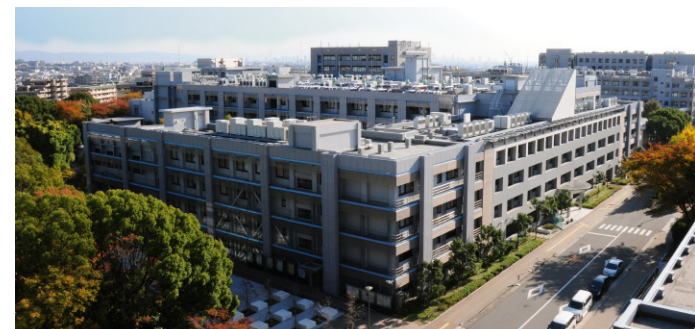
基礎工学部棟
